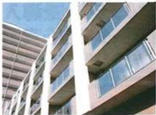
中層棟2~4階に設置した「アーレア戸建公園」のソラモ。一見、普通のパルコニーに見えるが、集熱パネルが一体化している
